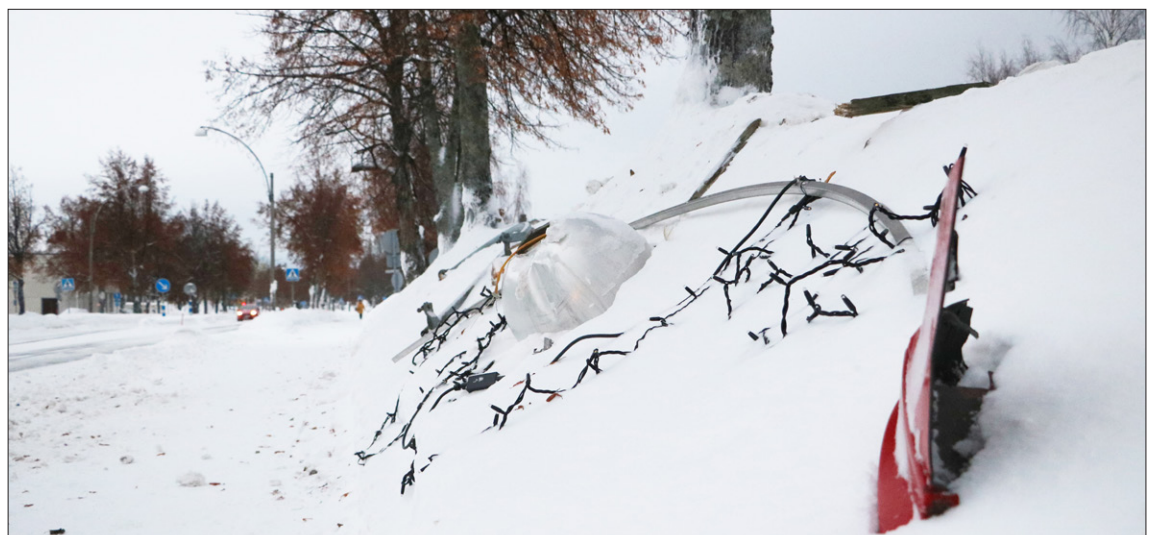
Kaatuneesta pylvästä irronnutta tavaraa oli siirretty pois kevyen liikenteen väylältä. Korjaustyöt suoritettiin maanantaina. KUVA: ELINA HYVÄRINEN
